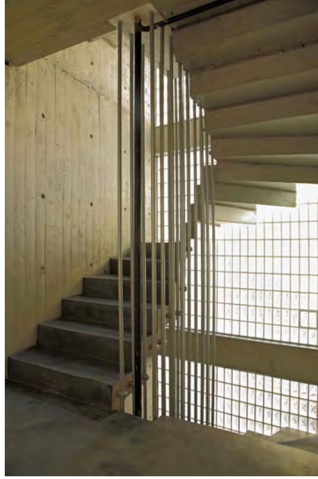
Şekil: 12 Merdiven ve malzeme kullanımı (URL-7).
