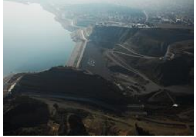
Şekil 1: Vali Recep Yazıcıoğlu Gökpınar barajı.
