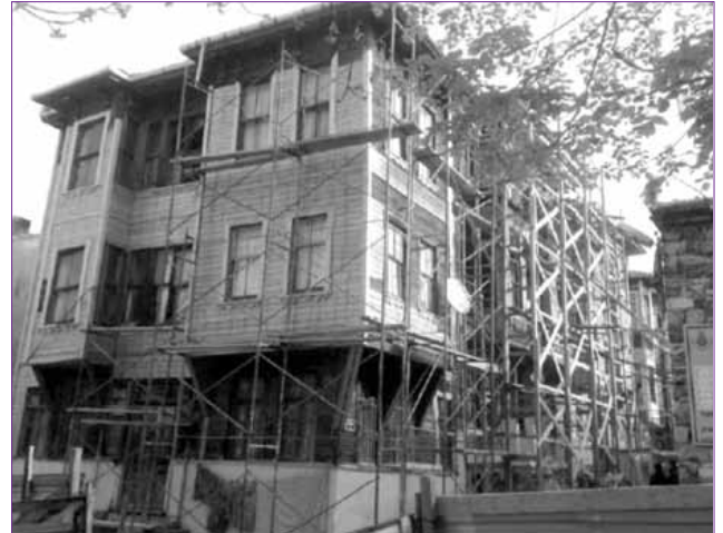
Şekil 3. Dış cephesi KUDEB tarafından yenilenen bir konut.
