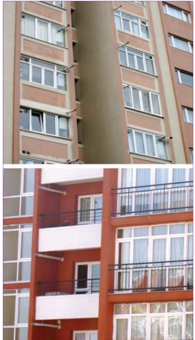
Şekil 1. C tipi denge bacalı (hermetik) aygıtların atık gaz çıkışlarının dış cephede düzenlenmesi.
