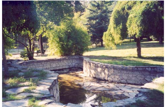
Resim 15. Bakımsız durumdaki yapay havuz, Maçka Parkı, İstanbul
