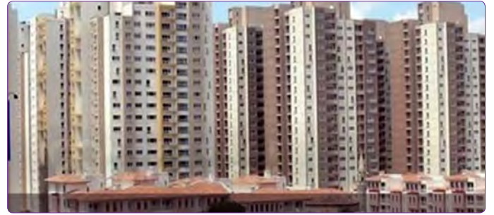
Şekil 5. Kentsel dönüşüm ile oluşan yeni konut dokusu örneği.
