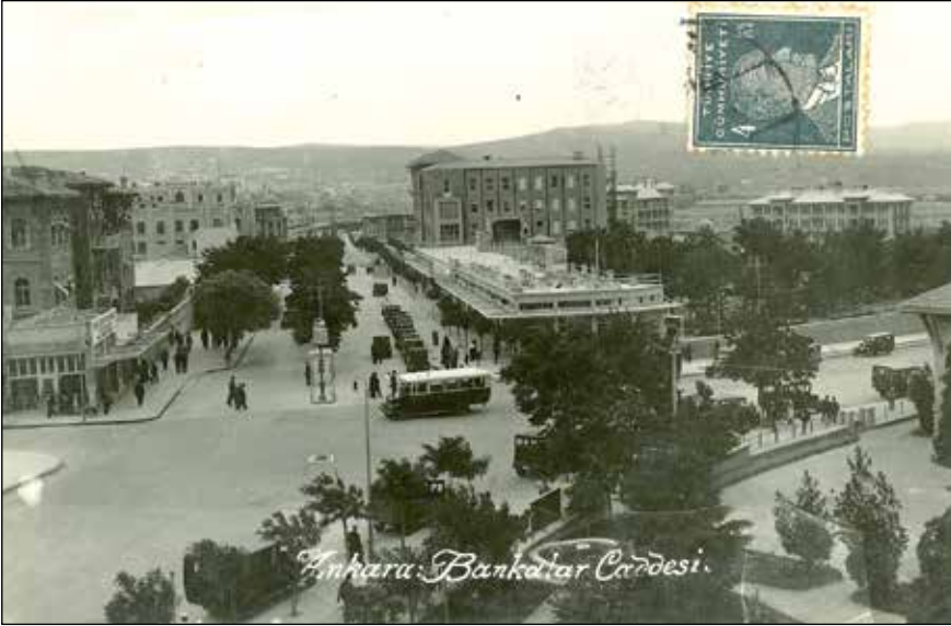
Şekil 15. 1934 yılından Bankalar Caddesi, Karpiç Lokantası, Şehir Çarşısı ve Şehir Bahçesi görünümü.
