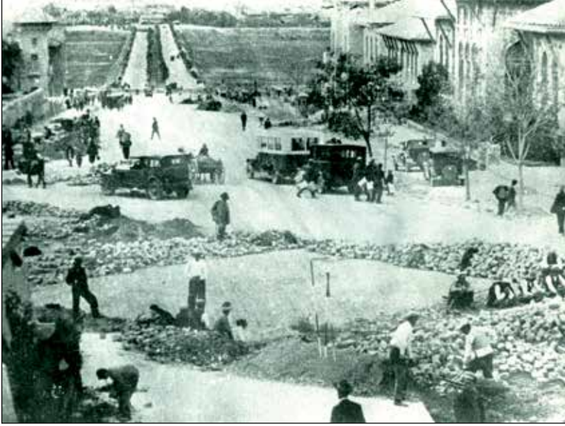
Şekil 11. Hakimiyet-i Milliye Meydanı parke taşı kaplanıyor, 1925. Kaynak: VEKAM Kütüphanesi ve Arşivi, Envanter No: 0010.
