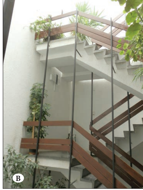
Şekil 26A. Çankaya İş Bankası ikramiye apartmanlarının galeri boşluğu ve çatı-penceresi. Fotoğraf: Umut Şumnu. Şekil 26B. Apartmanlarının galeri boşluğundaki metal profiller. Fotoğraf: Umut Şumnu.
