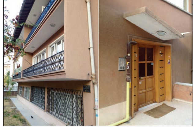
Şekil 5. Maltepe'deki Muhabank ikramiye apartmanının yıkılmadan önceki hâli.
